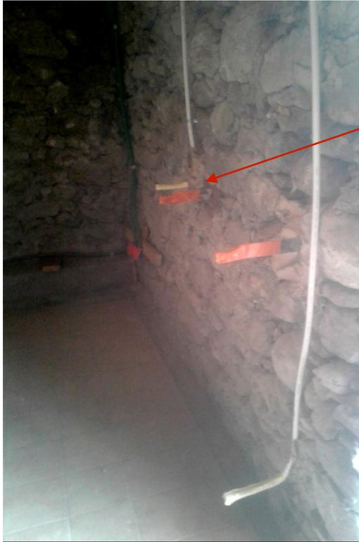
Scellement dans la maçonnerie des fixations de radiateurs (mortier au ciment prompt)
