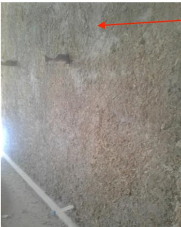
Fixation radiateur après projection du corps d'enduit en béton de chanvre.
