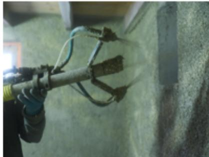
*Préparation de chantier pour l'isolation en béton de chanvre projeté et application d'une couche de finition manuelle.*
