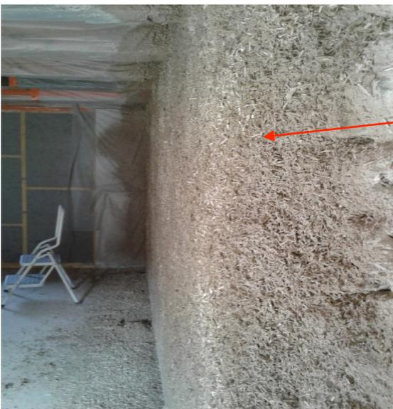
Corps d'enduit béton de chanvre projeté en 10 cm
