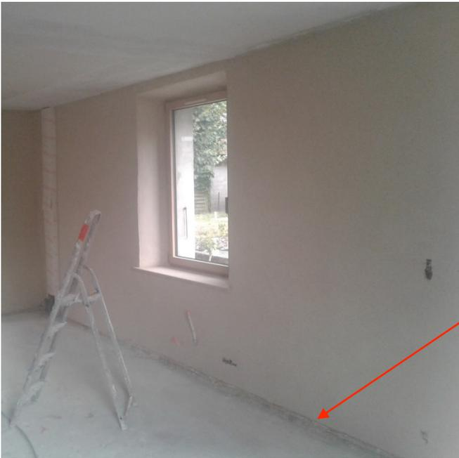
Lisse basse noyée dans la projection de béton de chanvre, la finition est ajustée au nu de la lisse, la plinthe vient se fixer directement en applique sur la finition.
